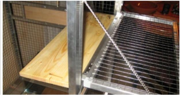
Jetzt fehlt noch ein Lande- und Abflugplatz im Bereich der Flugklappe und die Kette für die Klappe. Da wir bis jetzt alles so gebaut haben, dass man bei einer Reinigung der Voliere mit wenigen Handgriffen die Holzteile entfernen kann, haben wir uns für das Brett zwei Halterungen aus Alu Flachmaterial 20x2mm gebogen. Diese Halterung passt genau über das 20x20mm Rohr. Jetzt noch die Halterung an dem Brett verschrauben. Das Brett ist aus Fichte.
